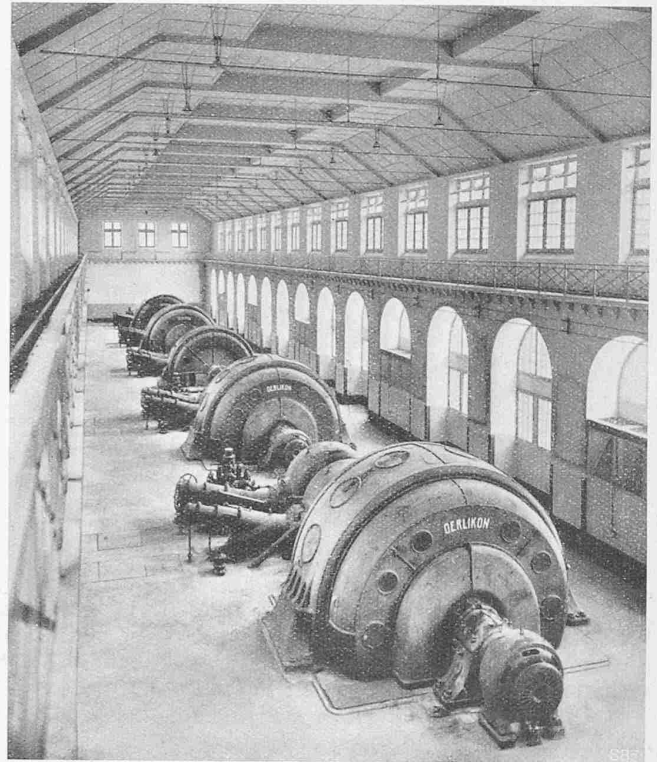
Abb. 83. Innenansicht des Maschinenhauses.
