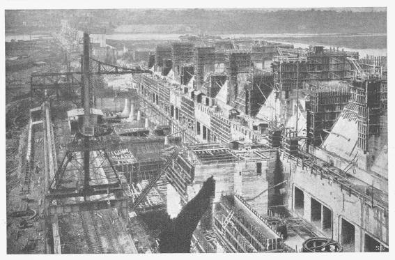
Abb. 7. Blick auf die Baustelle des Maschinenhauses; rechts die Turbinen-Einläufe.
