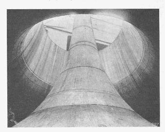
Abb. 8. Fertiges Saugrohr einer 35 000 PS-Turbine. (Man beachte den Mann links unten als Masstab).
