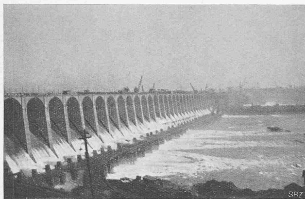
Abb. 5. Das Wilson-Stauwehr, vom rechten Ufer aus gesehen, mit teilweise geöffneten Ueberfall-Schützen.
