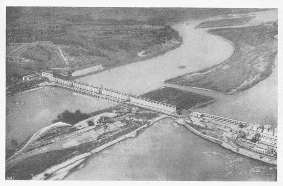
Abb. 2. Fliegerbild des Stauwehrs, rechts das im Bau befindliche Maschinenhaus, links die Arbeiterkolonie.
