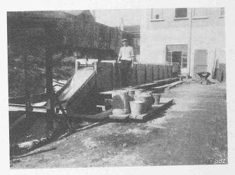
Abb. 2. Versuchsmodell 1:10 der Entsandungs-Anlage.
