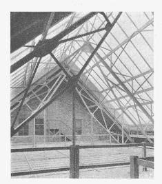
Abb. 79. Dachkonstruktion mit Oberlicht über dem Schaltstand.
