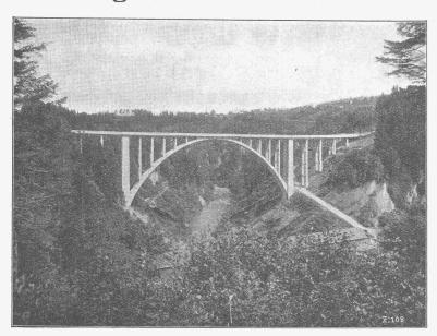
Hundwilertobelbrücke im Kanton Appenzell A.-R. Spannweite des Bogens = 105 m. Erbaut 1924/25. Projektierung u. Ausführung von Hoch- und Tiefbauten
