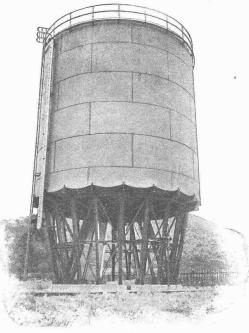
Genieteter Laugenbehälter von 1000 m<sup>3</sup> bezw. 1350 Tonnen Inhalt, 10,8 m Durchmesser, 12 m Höhe, mit Spezialbodenkonstruktion.
