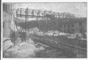
Bockkran, 20 t Tragfähigkeit, 28,5 m Spannweite für einen Steinlagerplatz (Marmorlager). Societa Ligura Marmitera, Carrara.
