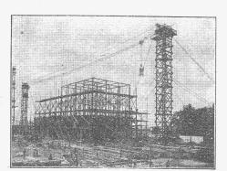
Bleichert-Kabelkram für Hochbauten
