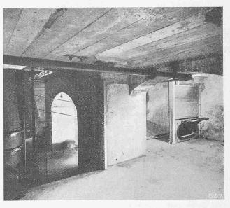
Abb. 18. Eichreservoir mit einsetzbaren Wänden. Rechts Schnellschlussklappe.
