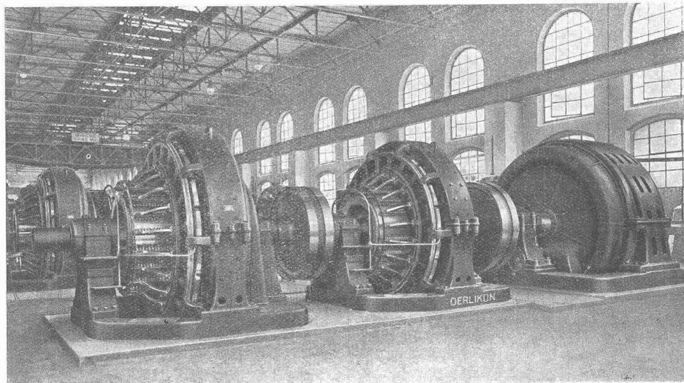
**Grosse Gleichstrom-Generatoren und Einanker-Umformer für Elektrochemie.**
