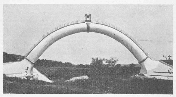
Abb. 3. Ansicht des Eisenbeton-Rohrbogens über den Rio Majaceite in Südspanien.
