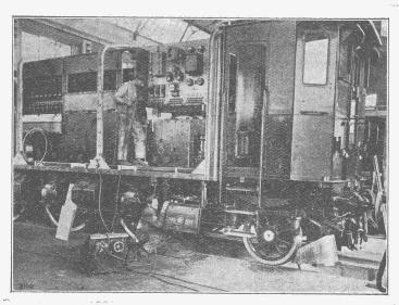
Montage de locomotives Soudure d'une protection en tôle au moyen d'un appareil "Sécheron".
