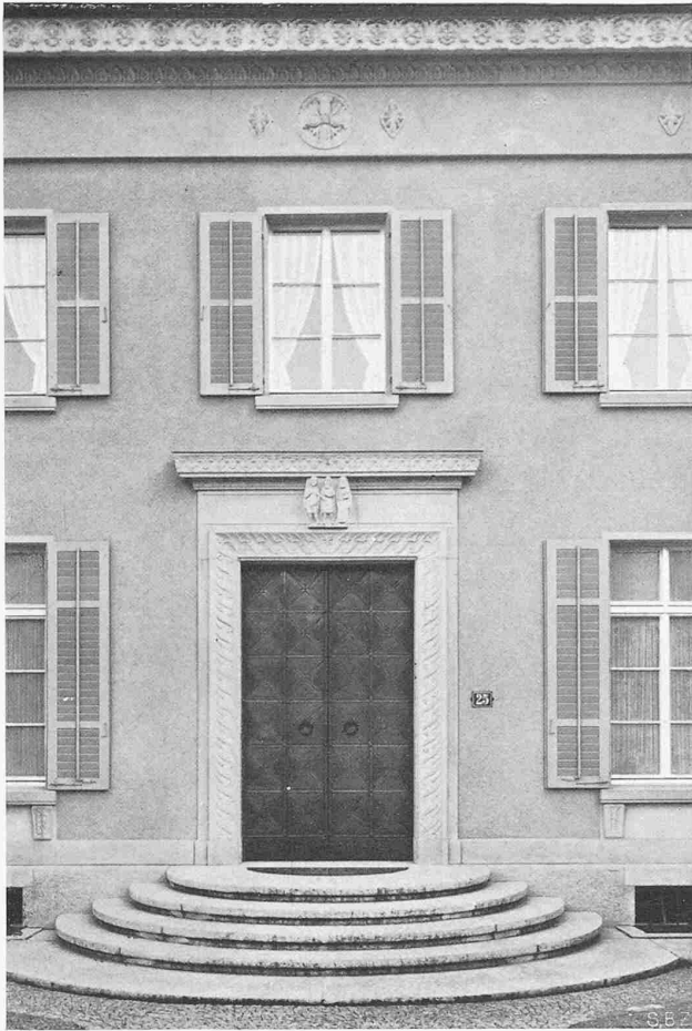
HAUPTINGANG NORDSEITE UNTEN DER WESTEINGANG
