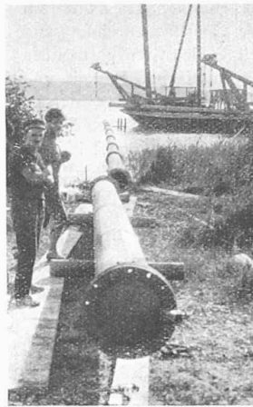
Fig. 11. Lançage par flottaison du tronçon de rive.
