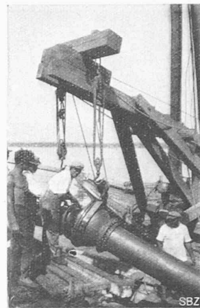
Fig. 8. Détail d'une articulation de la conduite.
