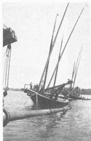
Fig. 7. Tronçon de conduite en voie d'immersion.
