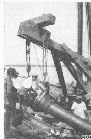
Fig. 8. Détail d'une articulation de la conduite.
