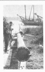
Fig. 11. Lançage par flottaison du tronçon de rive.
