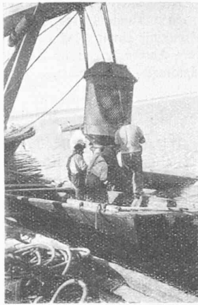
Fig. 10. Boulonnage de la crépine à l'extrémité de la conduite.
