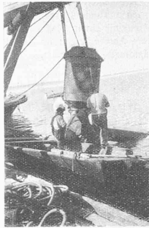
Fig. 10. Boulonnage de la crépine à l'extrémité de la conduite.
