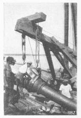
Fig. 8. Détail d'une articulation de la conduite.
