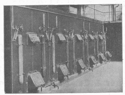
Sechs Sulzer-Niederdruck-Dampfkessel von 0,25 Atm. mit zusammen 183 m² Heizfläche.
