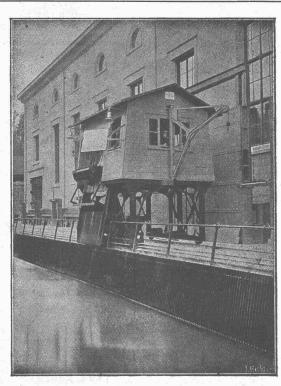
ELEKTRIZITÄTSWERK WYNAU-LANGENTHAL Kombinierte Rechen-Reinigungsmaschine mit doppeltem Schwenkkran
