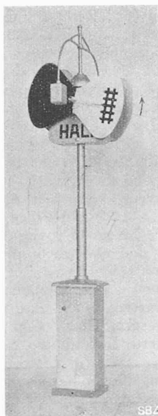
Abb. 8. Automat. Drehflügel-Signal der Hasler A.-G., Bern.
