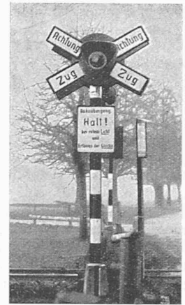
Abb. 6. Blinklicht-Signal der Signum A.-G. Wallisellen.
