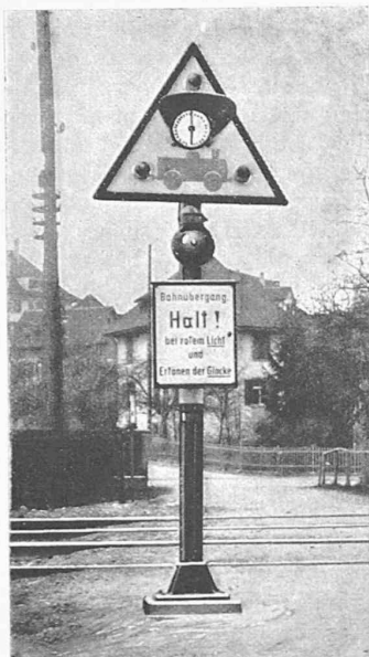
Abb. 7. Blinklicht-Signal mit drei Lampen der Signum A.-G., Wallisellen.
