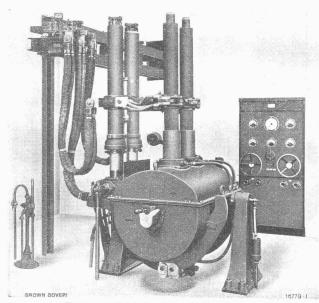
Elektrischer Metallschmelzofen für Dreiphasenstrom, mit hydraulischer Hand- und automatischer Elektrodenregulierung. Fassungsvermögen 600 kg. Ansicht von der Ausgusseite.
