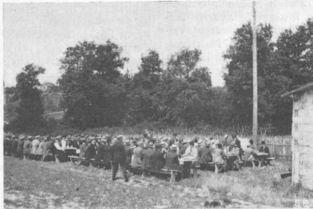
Fig. 8. On fait du butin près du pont du même nom.
