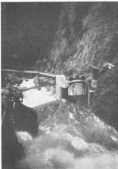
Abb. 47. Fellibach-Staumauer und Grundablass von oben gesehen, bei Hochwasser.
