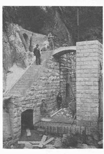
Abb. 46. Einlauf (hinten) und Spülauslass; oben Eingang zur Apparatenkammer.
