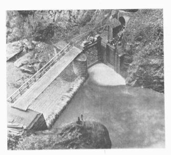
Abb. 48. Fellibach-Staumauer mit Grundablass und Einlauf.
