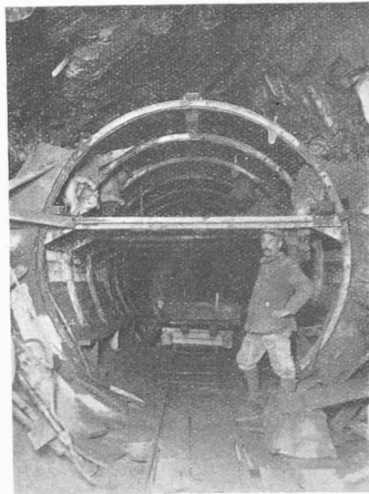
Abb. 35. Lehrbogen der Kreisprofilstrecken.
