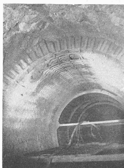
Abb. 41. Torkretierung eines Versuchsringes mit Doppelarmierung, Typ VII. (29. III. 1921.)
