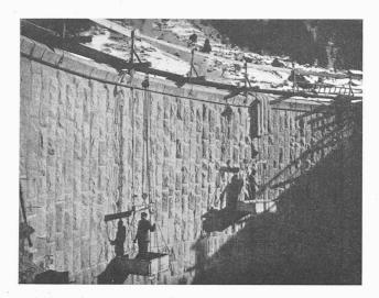
Abb. 16. Ausrammen der offenen Gewölbefugen (30. l. 22).
