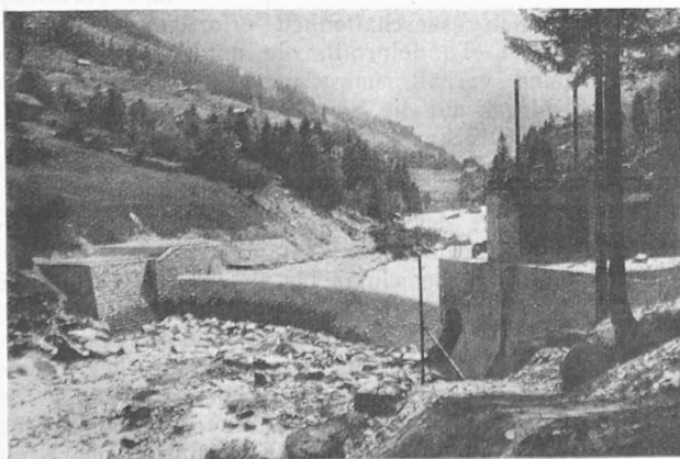
Abb. 6. Leitwehr (Unterwasserseite), rechts Tunnel-Einlauf.
