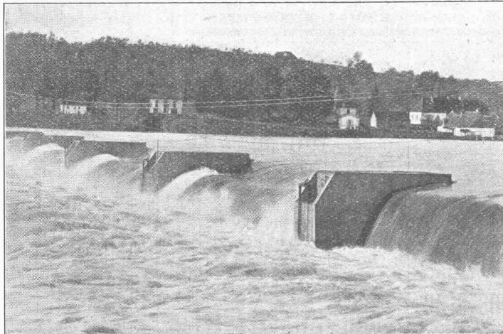
Ausgef\u00fchrt und im Bau \u00fcber 2800 Meter Wehrbreite f\u00fcr zirka 28 000 m\u00b3/sec Regulierf\u00f6rmigkeit.
