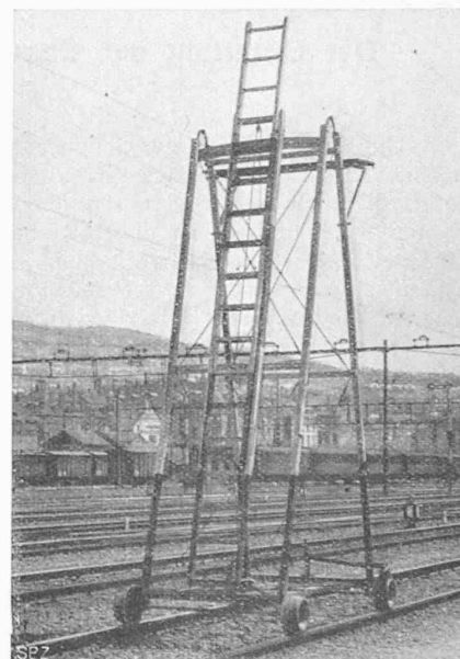
Abb. 4. Roll-Leiter für Fahrleitungs-Montage.
