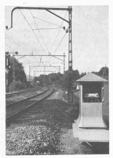
Abb. 6. Kabelbude mit Telephon-Anschluss.
