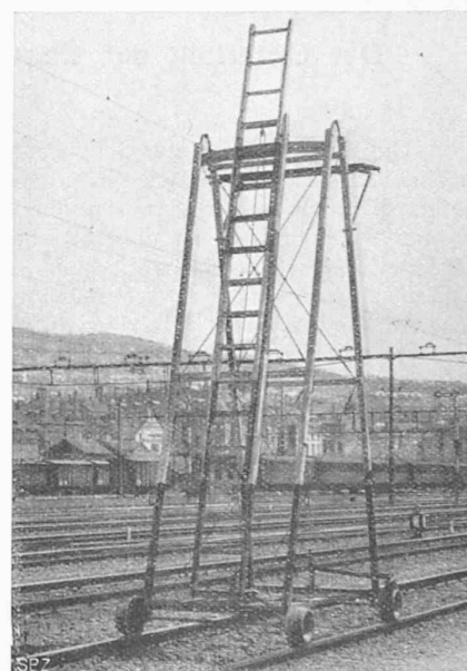
Abb. 4. Roll-Leiter für Fahrleitungs-Montage.
