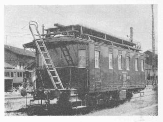
Abb. 5. Reparaturwagen für Fahrleitungs-Anlagen.
