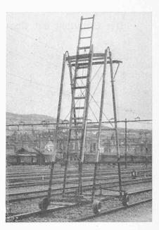
Abb. 4. Roll-Leiter für Fahrleitungs-Montage.
