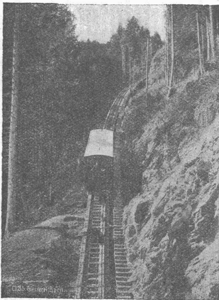
Seilbahn Niesen, I. Sektion, maximale Steigung 66%.
