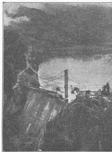
Bleichert-Kabelkran beim Talsperrenbau
