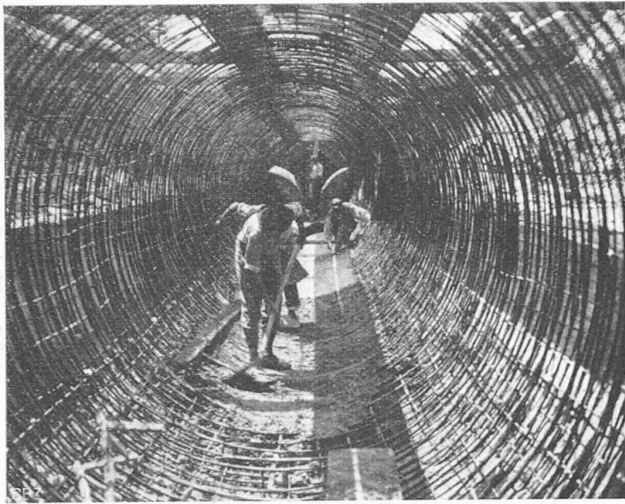
Abb. 5. Bewehrung des Rohrstrangs.
