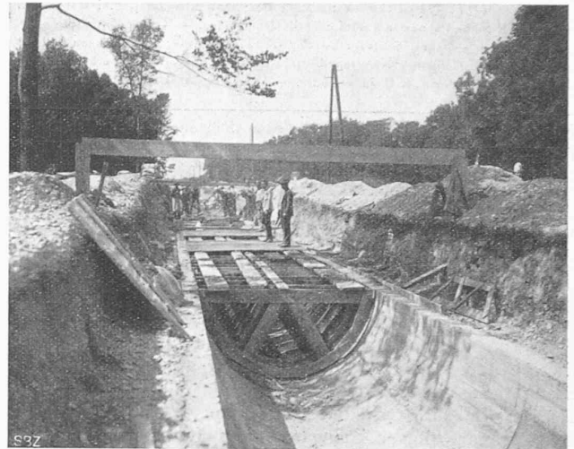
Abb. 4. Sohle des Rohrstrangs.
