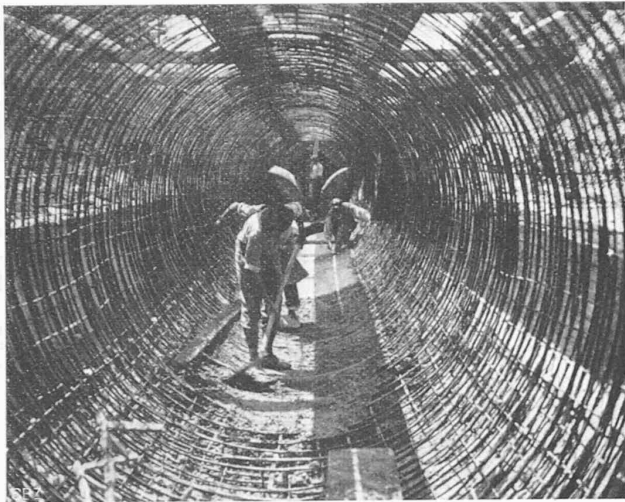
Abb. 5. Bewehrung des Rohrstrangs.
