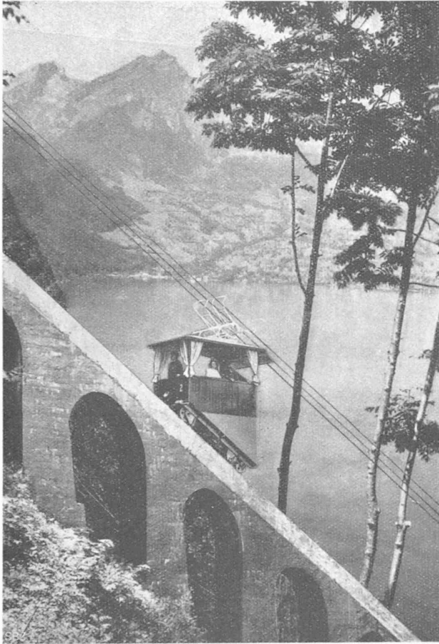
Abb. 2. Viadukt der Seilbahn, mit Blick auf den Pilatus.
