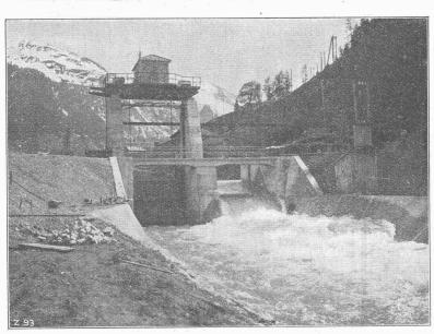
Wasserfassung des Kraftwerks Klosters-Küblis Ausgeführt 1920/21.
