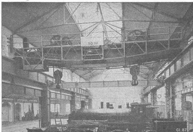
Lokomotivhebeke von 50 Tonnen Tragkraft, in den Reparaturwerkstätten der S. B. B. in Zürich.
