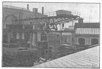
Hof-Lauskran, Tragkraft 15 Tonnen, Länge 23 m, mit einseitigem festen Ausleger.
