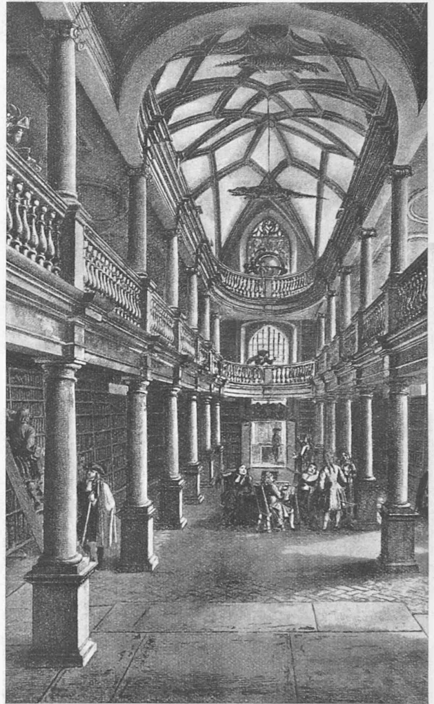
Abb. 4. Wasserkirche mit den heute noch bestehenden Galerie-Einbauten.
