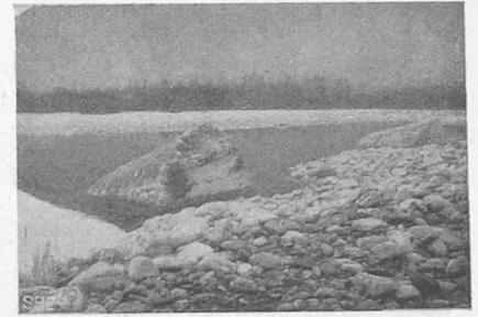
Abb. 8 und 9. Isolierte Beton-Buhnen in der Verzasca bei Tenero (Kt. Tessin).
