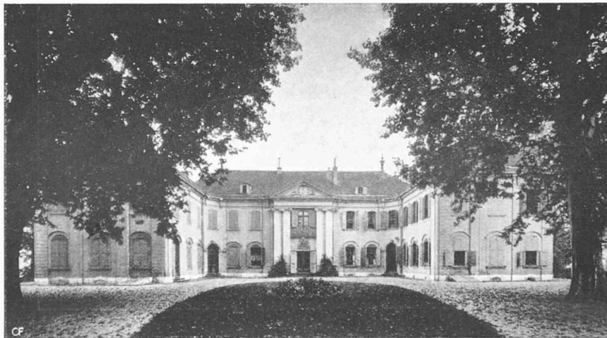
Château de Crans, Nordfassade, Riss nebenstehend
