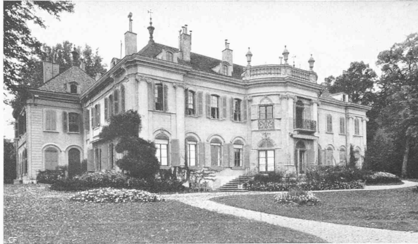
Château de Crans, Südfassade, Riss nebenstehend
