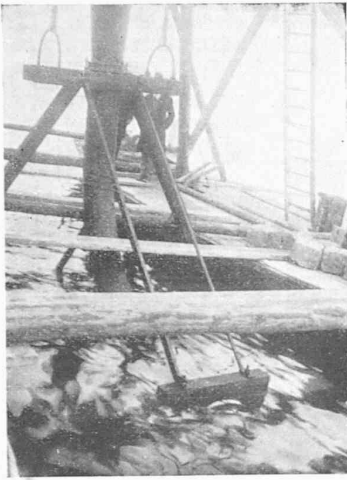
Abb. 2. Aus dem Wasser herausragendes vorderes Ende der Leitung.
