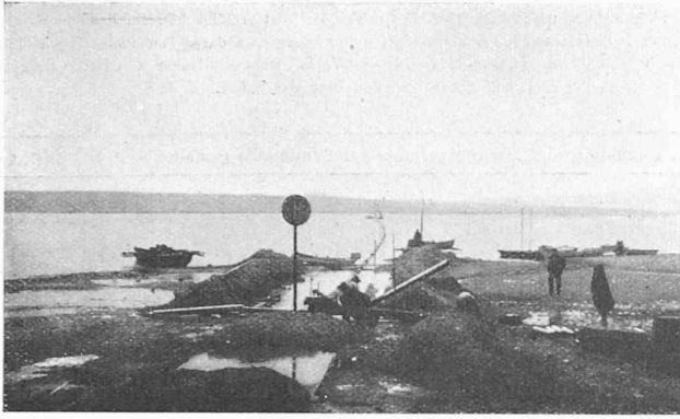
Abb. 3. Die schwimmend verlegte Leitung vor deren Versenkung.
