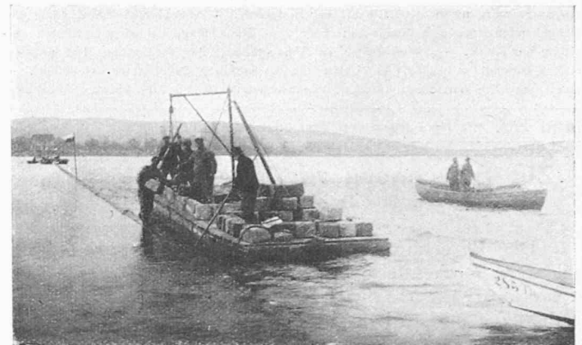
Abb. 4. Belastung der Leitung mit Betonblöcken.
