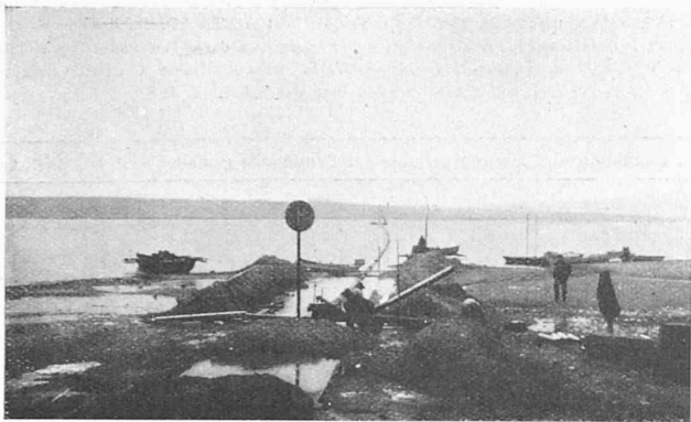
Abb. 3. Die schwimmend verlegte Leitung vor deren Versenkung.
