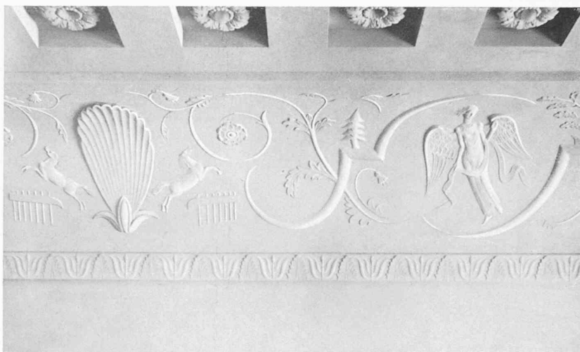
KEHLE UND DECKEN-DETAIL AUS DER AULA
