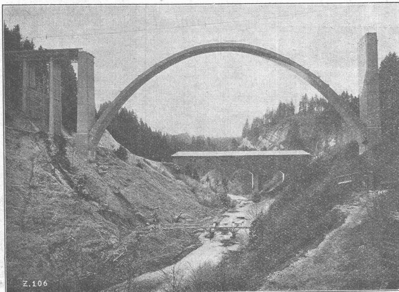
Hundwillertobelbrücke bei Waldstatt (Kt. Appenzell A.-Rh.) Eisenbetonbogen von 105 m Spannweite,
