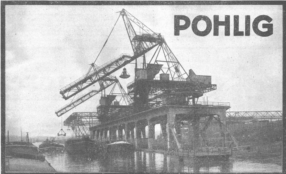
Größte Elektrohängebahnanlage der Welt. Stündliche Leistung 500t. Bild 1: Uferentlader mit Kaistrocke der Elektrohängebahn
