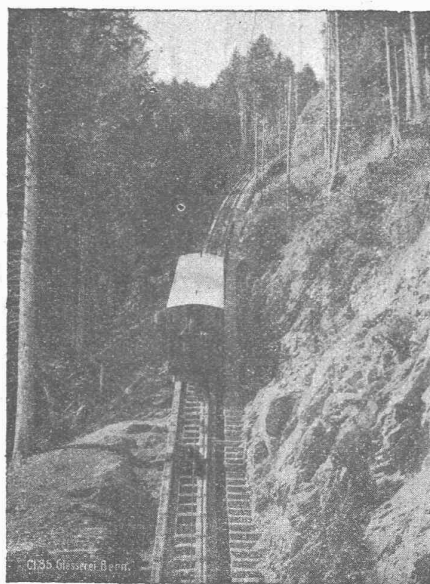
Seilbahn Niesen, I. Sektion, maximale Steigung 66 %.
