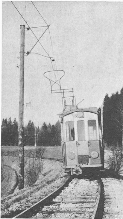
Abb. 2. Fahrleitung der Uetlibergbahn.
