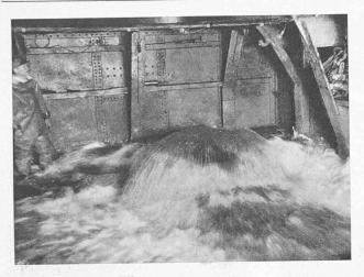
Abb. 13. Quelle in Schwelle 5 des Stauwehrs Augst-Wyhlen aus einem 70 cm weiten Eisenrohr auf Blockhöhe austretend (15. I. 1921).
