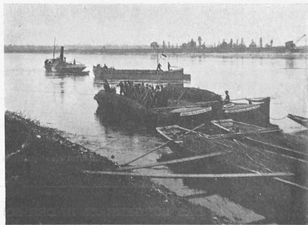
Abb. 4. Abrollen einer fertigen Senkwurst.
