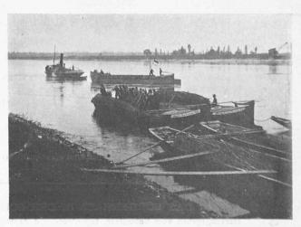
Abb. 4. Abrollen einer fertigen Senkwurst.
