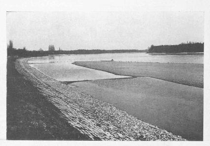
Abb. 6. Unterbindung einer Nebenrinne durch Buhnen-Einbau.
