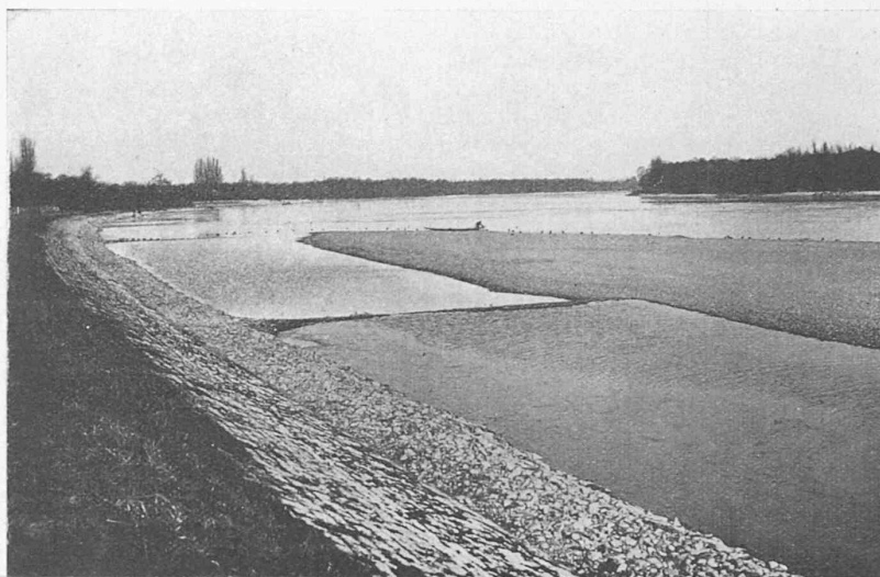
Abb. 6. Unterbindung einer Nebenrinne durch Bühnen-Einbau.
