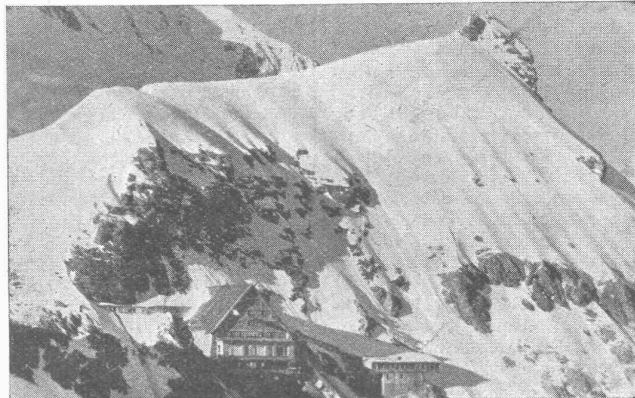
Gletscherwasser während des Druckes mit «SIKA» gedichtet und mit «Antifrost» betoniert
