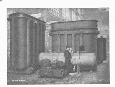
Mit Brown Boveri Lichtbogen-Schweißgruppen elektrisch geschweißte Groß-Transformatorenkessel.
