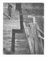
Abb. 3 und 4. Einzelheiten der Gewölbe-Längsfugen im Pont Butin.
