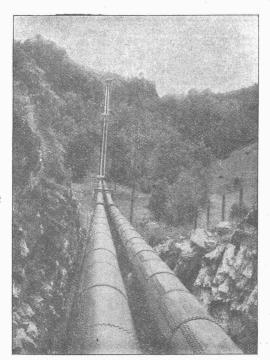
Druckleitungen I und II von 1200 und 1300 mm Durchmesser für das Kraftwerk Lungernsee
