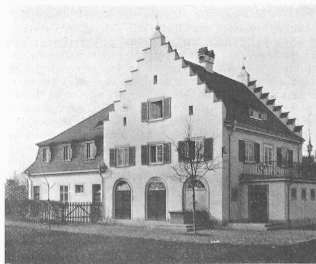
Abb. 2. Städt. Dienstgebäude auf der Breite in Schaffhausen. Arch. O. Vogler.
